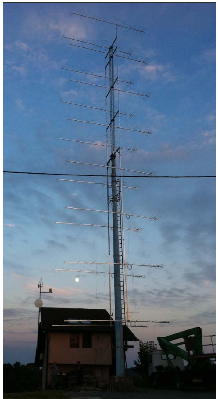
Fig. 16: The 9A2AE 16 x 11 el. 2m array
